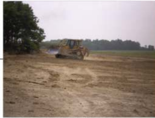
Remise en état à l'aide d'un buteur (Essarts des Bruyères)
