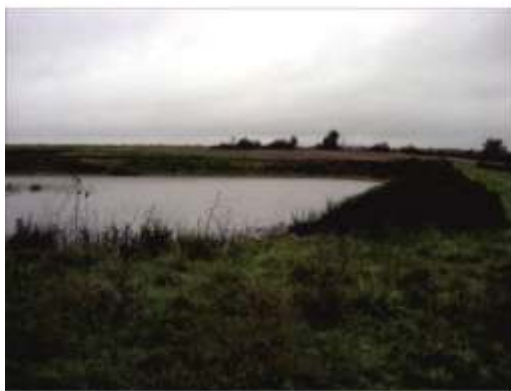
Réaménagement terminé (Essarts de Pazereux)
