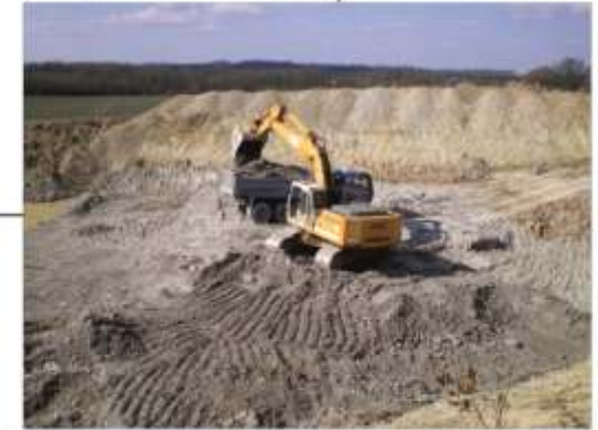
Extraction de l'argile à l'aide d'une pelle mécanique et d'un camion benne (Essarts des Bruyères)
