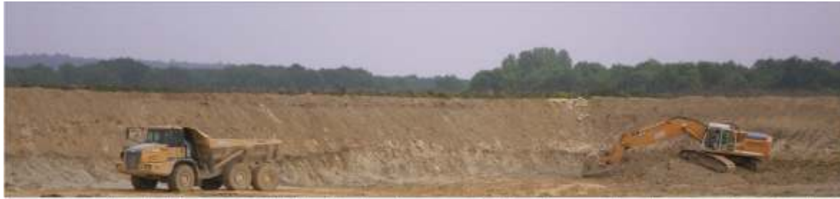
Terrassement de la découverte à l'aide d'un tombereau articulé et d'une pelle mécanique (Essarts des Bruyères)
